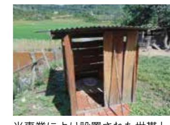
当事業により設置された世帯トイレの外観
