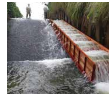
鉄骨仮設魚道の設置
