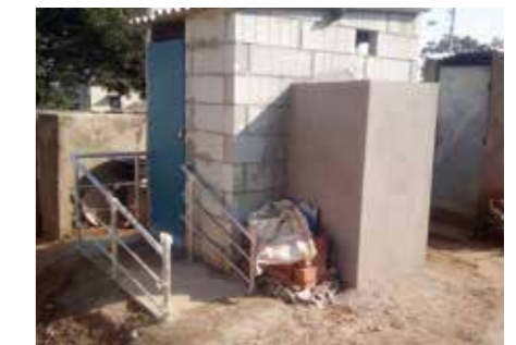
新しく設置されたアクセシブルトイレ
