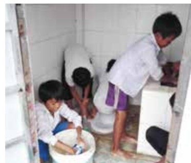
中学校のトイレを修繕後、清掃
