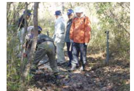
美佐野街道の湿地部分の補修
