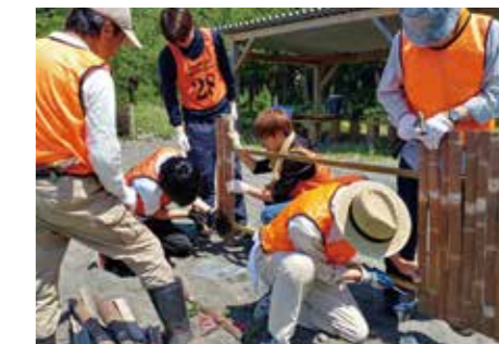
砂の飛散を防ぐための竹垣を設置
