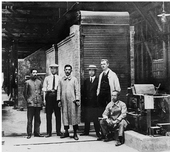
ドレスラー式トンネル窯第1号の築造記念(1919年)
