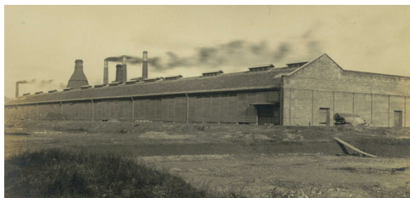
ドレスラー式トンネル窯第1号を納めた工場建屋(1920年)
