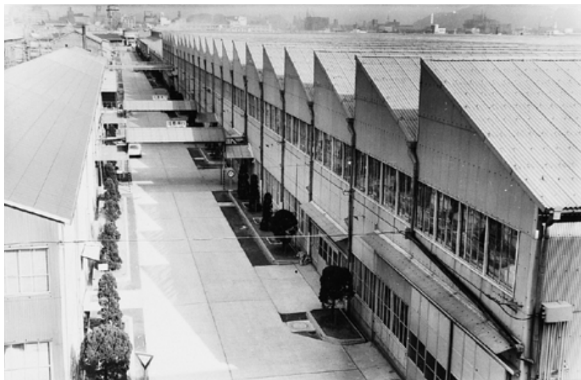
合理化した水栓金具工場
