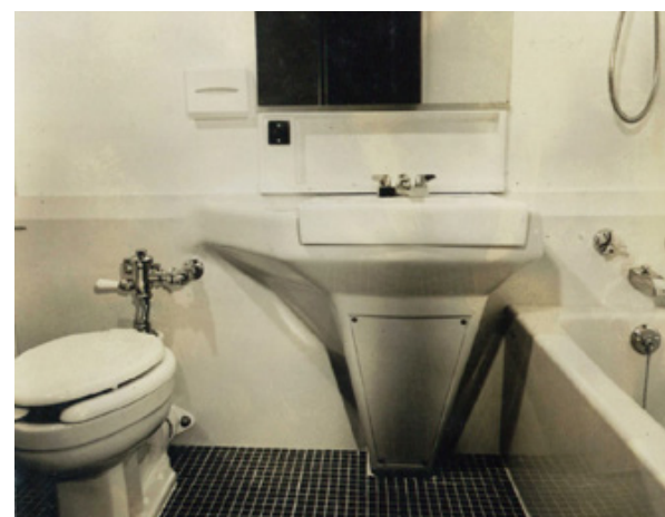
ホテルニューオータニに納入したユニットバスルーム
