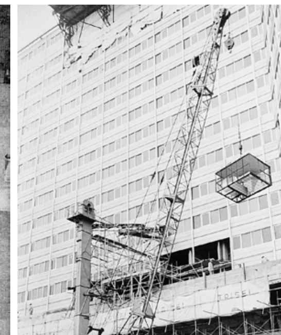
ホテルニューオータニへのユニットバスルーム搬入風景
