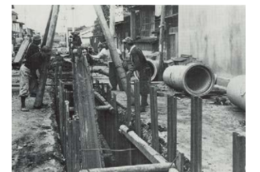
近代化のための下水道工事 (1961年、小田原市提供)
