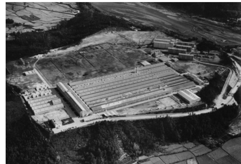
滋賀工場（1962年） 急速に増大する需要に対処するため、衛生陶器の第3の拠点として建設した。
