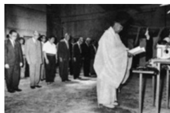
旧衛陶工場解体式
