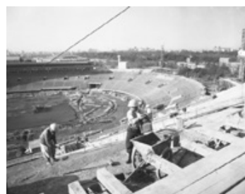
国立競技場の建設風景 (1962年、共同通信社提供)
