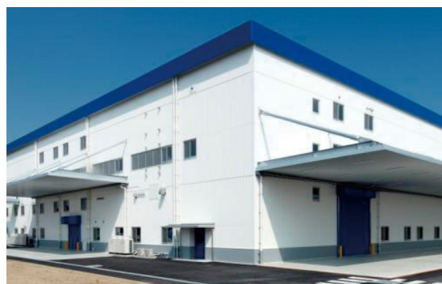
TOTOサニテクノ株式会社滋賀工場の新西棟
