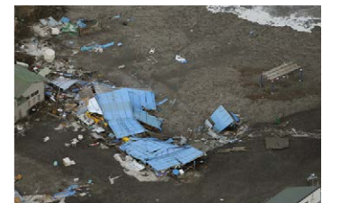
東日本大震災で被害を受けた建物（2011年、共同通信社提供）
