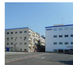
① 小倉第一工場 ・福岡県北九州市小倉北区中島2-1-1
